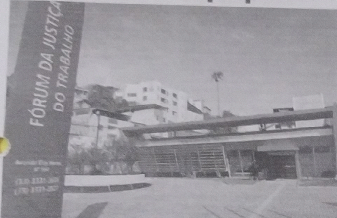
Sede própria do Tribunal Regional do Trabalho de Manhuaçu, que está localizada na Avenida Eloy Werner, 560, ao lado da BR-252
